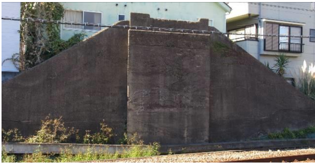
図7 八王子煉瓦関連施設
