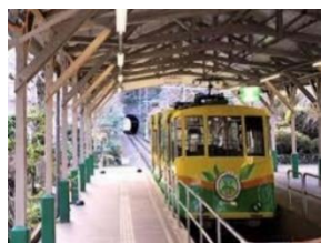
図8 現在のケーブルカー
