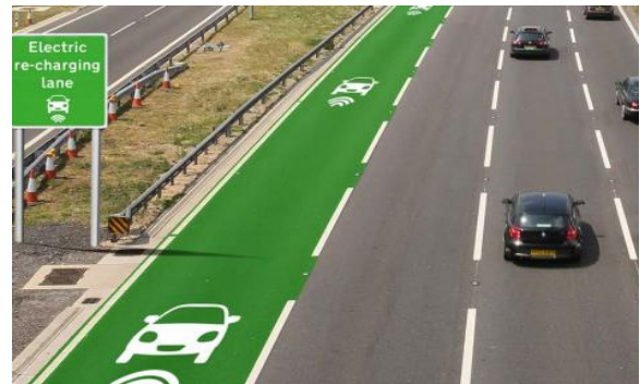
図1 移動体への非接触給電のイメージ [1]
