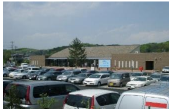
図1 道の駅八王子滝山
